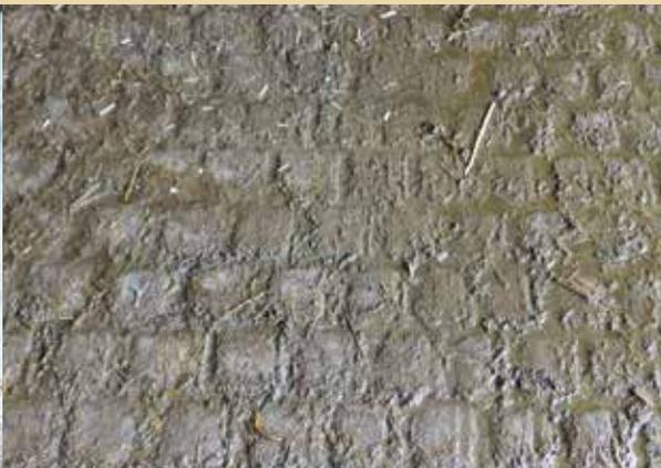
Le béton du couloir de circulation entre le bloc traite et le bâtiment est bouchardé (empreinte réalisée sur béton frais).
