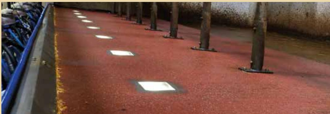
*Le rétro éclairage des quais est réalisé avec des pavés translucides haute-résistance.*
