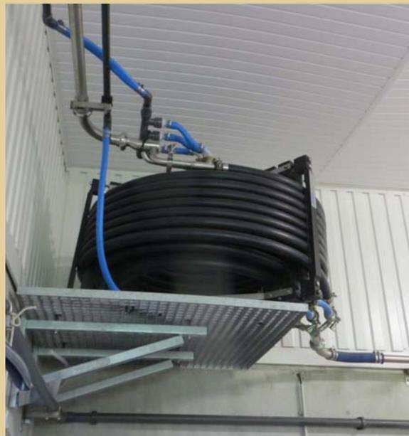
Le pré refroidisseur de lait tubulaire permet d'économiser sur la consommation électrique du tank à lait
