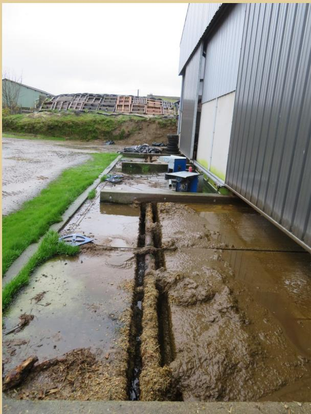
Deux racleurs à corde indépendants permettent de racler efficacement le lisier dans un canal de transfert.
