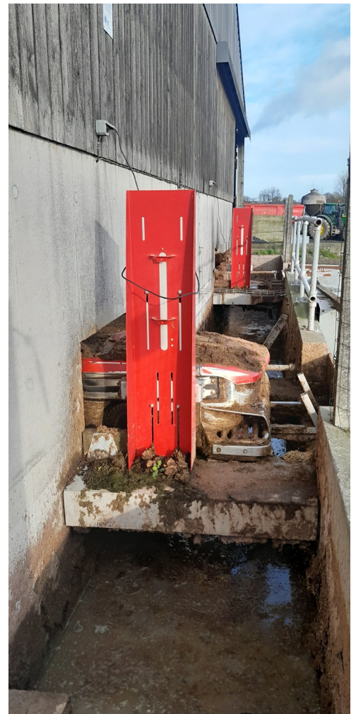
Une préfosse collecte le lisier déversé par les aspirateurs. Le lisier est transféré par pompe vers le pré stockage et la méthanisation.
