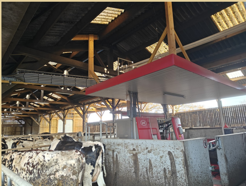
L'espace robot est protégé par un faux-plafond.
