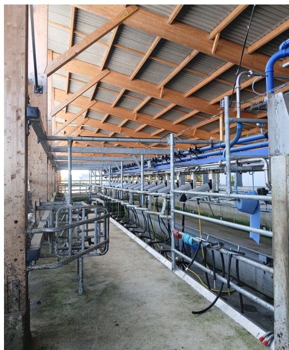
Salle de traite 2x16 simple équipement
