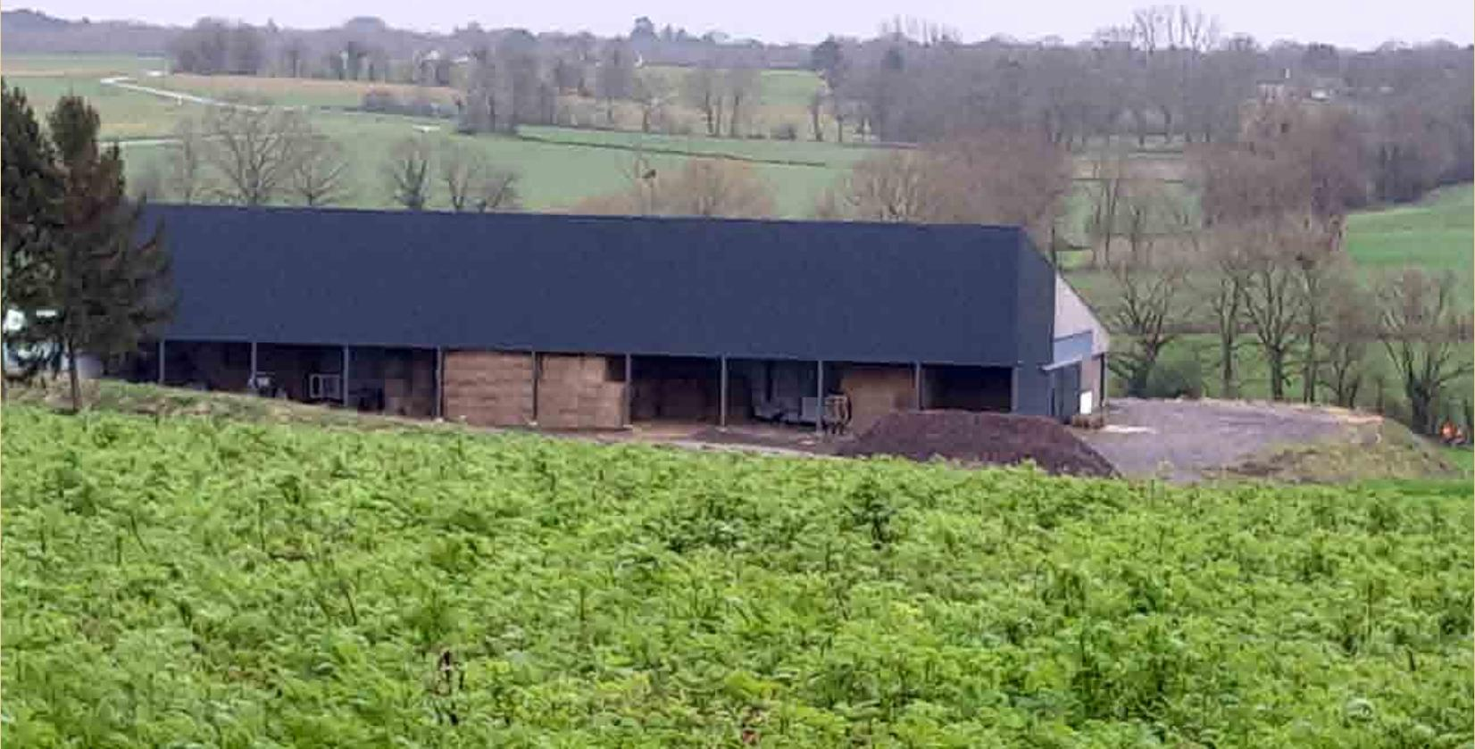
Pour le bâtiment des génisses, un traitement spécifique des façades avec un bardage sombre, permet de réduire l'impact paysager de la construction monopente équipée de panneaux photovoltaïques.
