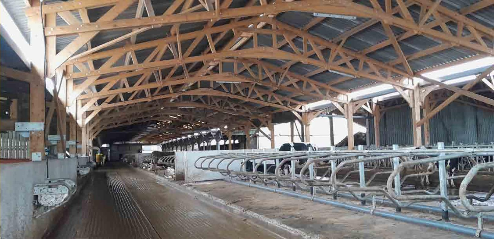
La stabulation neuve n'est pas éclairée en toiture par des translucides. La luminosité vient des décalages en longs pans. De nombreux abreuvoirs équipent le bâtiment le long du couloir.
