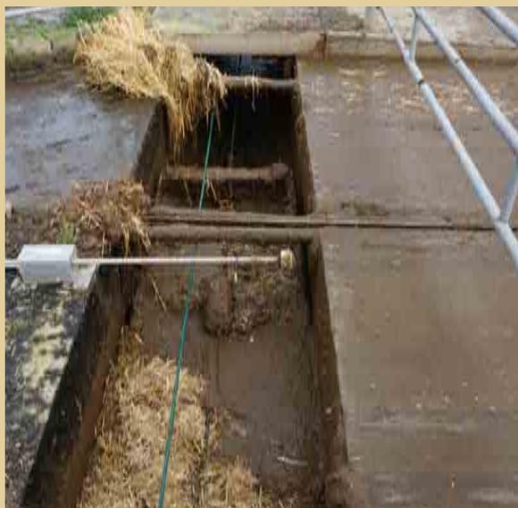
Le canal à lisier est équipé d'un évacuateur qui facilite le transfert vers la fosse à lisier.
