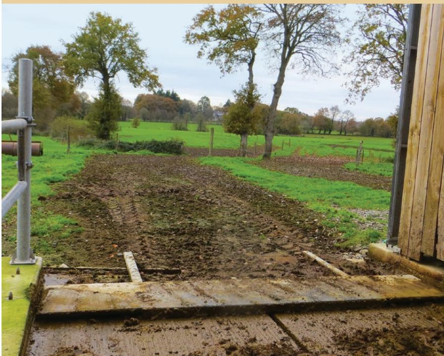
*À la sortie des vaches vers le pâturage, le franchissement du canal à lisier se fait par-dessus une trappe qui se lève automatiquement à l'arrivée du racleur.*
