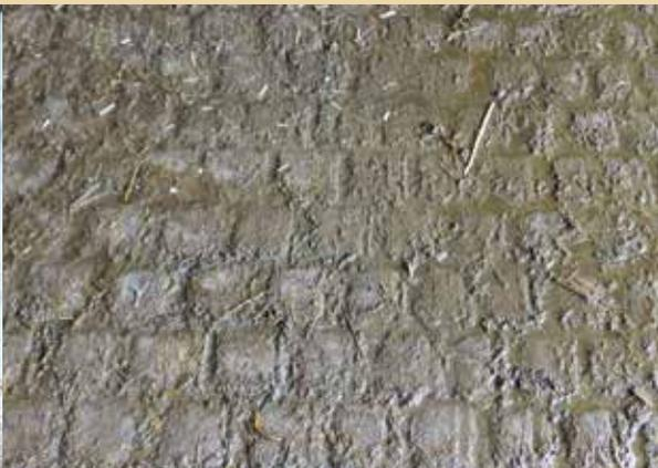
*Le béton du couloir entre le bloc traite et le bâtiment est bouchardé (empreinte réalisée sur béton frais).*
