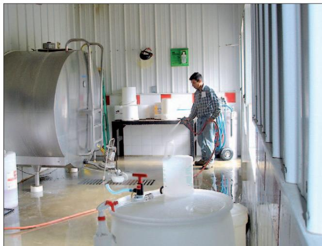
Afin de combiner plusieurs solutions de valorisation, les circuits d'évacuation de l'eau du pré-refroidisseur doivent être conçus de manière à la répartir entre les différents postes. Cela est possible en jouant sur les diamètres de tuyauteries employés ainsi qu'en équipant les différentes cuves de stockage de flotteurs.
