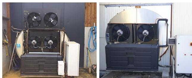
*Deux des prototypes TANK2020 installés en 2020 dans des élevages laitiers d'Ille-et-Vilaine. Un suivi des performances des équipements a été réalisé sur plusieurs mois.*
