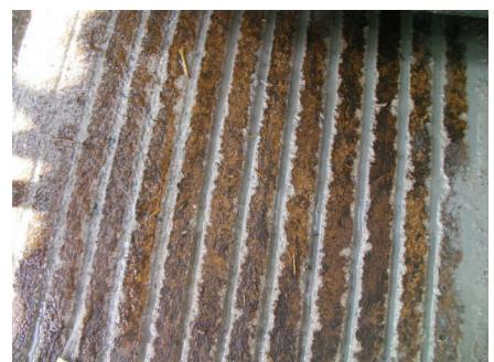
A la construction des aires bétonnées de circulation il faudra veiller à la bonne réalisation de la dalle. Elle doit reposer sur un sol correctement préparé, compacté et empierré dans les règles de l'art.
