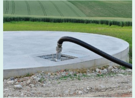
Fosse béton couverte
