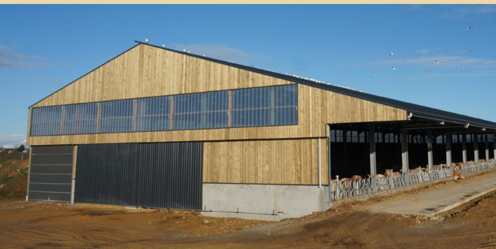
*La façade nord-ouest est protégée mais lumineuse grâce aux plaques translucides perforées, et aux nombreux translucides sur la toiture non exposée au soleil.*
