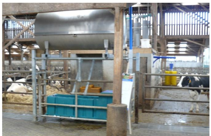
Ici un ancien tank à lait en hauteur valorise l'eau du pré-refroidisseur dans un seul abreuvoir de grande capacité.
