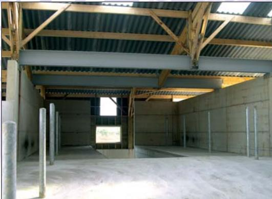
Le bloc de traite se décompose en trois locaux contigus : l'aire d'attente, la salle de traite et la laiterie.
