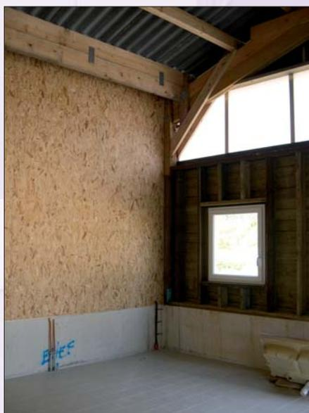
En cloisons intérieures et séparatives, sur sous-bassement maçonné, les panneaux d'OSB 3 permettent des finitions économiques. L'insertion de fenêtre et bandeau éclairant est facilitée par une paroi réalisée en ossature bois.
