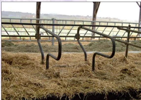
Des poteaux sur dés permettent des transformations aisées pour installer des logettes ou agrandir la stabulation.
