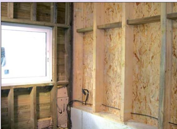
En habillage sur paroi extérieure du bureau de l'exploitation, l'ossature bois est très adaptée avec un bardage bois jointif. Pour le rendre étanche, il faut y tendre un film "pare-pluie" entre chevrons et bardage. Cette conception permet de passer aisément les câblages électriques et d'isoler suivant le besoin la paroi entre les montants de l'ossature.
