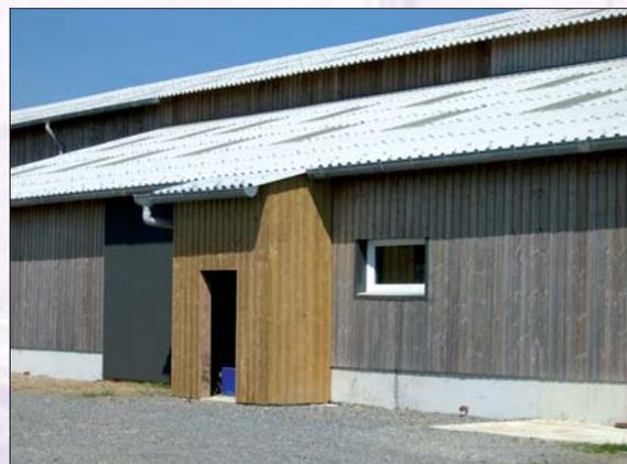
Un mur abaissé en périphérie permet de descendre le bardage bois à 60 cm du sol, ouvrage et voirie finis. Cette conception assure une assise harmonieuse à la construction et donne une belle image de l'exploitation laitière.
