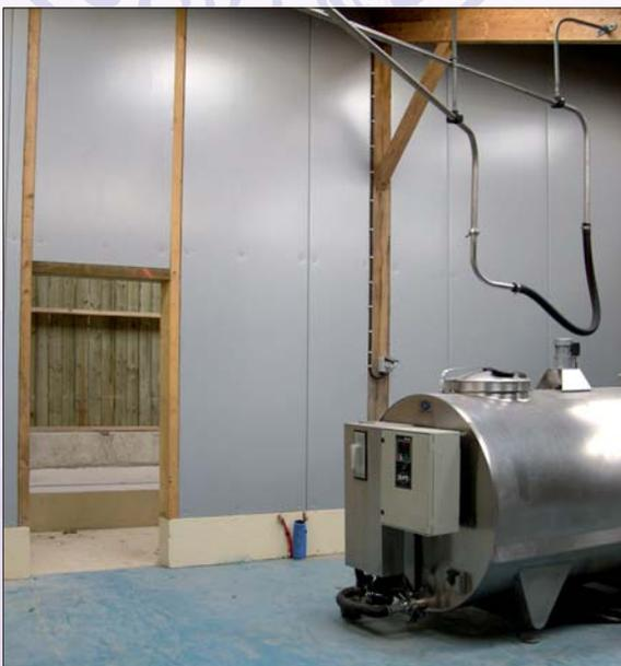
Vue intérieure de la laiterie avec un habillage étanche, sur la face intérieure de la paroi, posé sur un muret en béton banché de 60 cm de hauteur.
