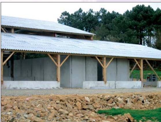
Au centre, le "cube" en béton banché de la salle de traite est indépendant. En pourtour, des murs bas portent les poteaux (banche de 0,75 m posée à l'horizontale sur la semelle lors du coulage).
