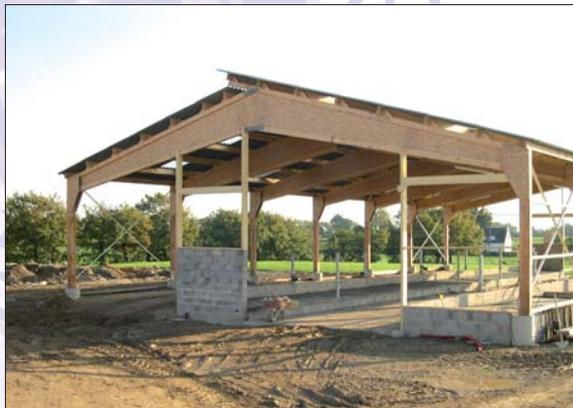
Les poteaux reposent sur les dés isolés. Des murets de parpaings remplissent les intervalles selon les besoins.
