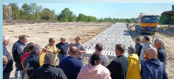
Projet de stabulation en construction à l'ouest du bloc traite.
