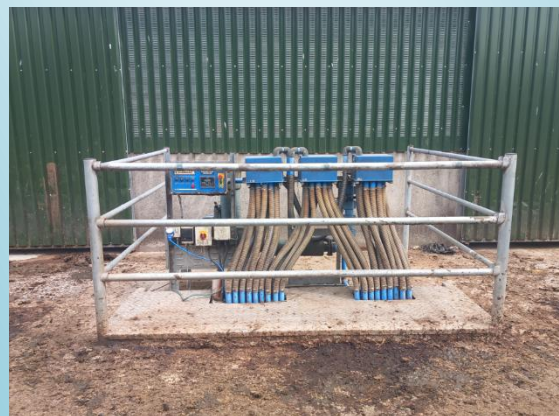
Dans les anciennes stabulations sur caillebotis, de l'air est injecté dans la fosse à lisier pour maintenir le lisier liquide et éviter qu'une croûte ne se développe. Ce procédé permet d'améliorer le transfert des déjections liquide vers le sol et de réduire les odeurs. L'équipement est coûteux.
