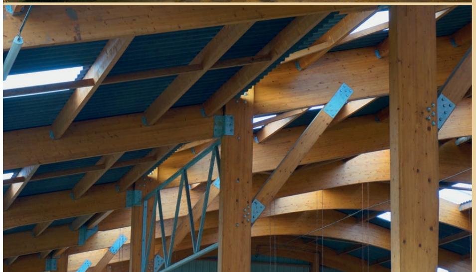
*On peut voir dans la qualité de cette charpente lamellé-collé les contreventements en structure métallique, mais aussi les anti-dévers qui retiennent le flambement des pannes. Deux décrochés de toiture assurent une bonne ventilation.*
