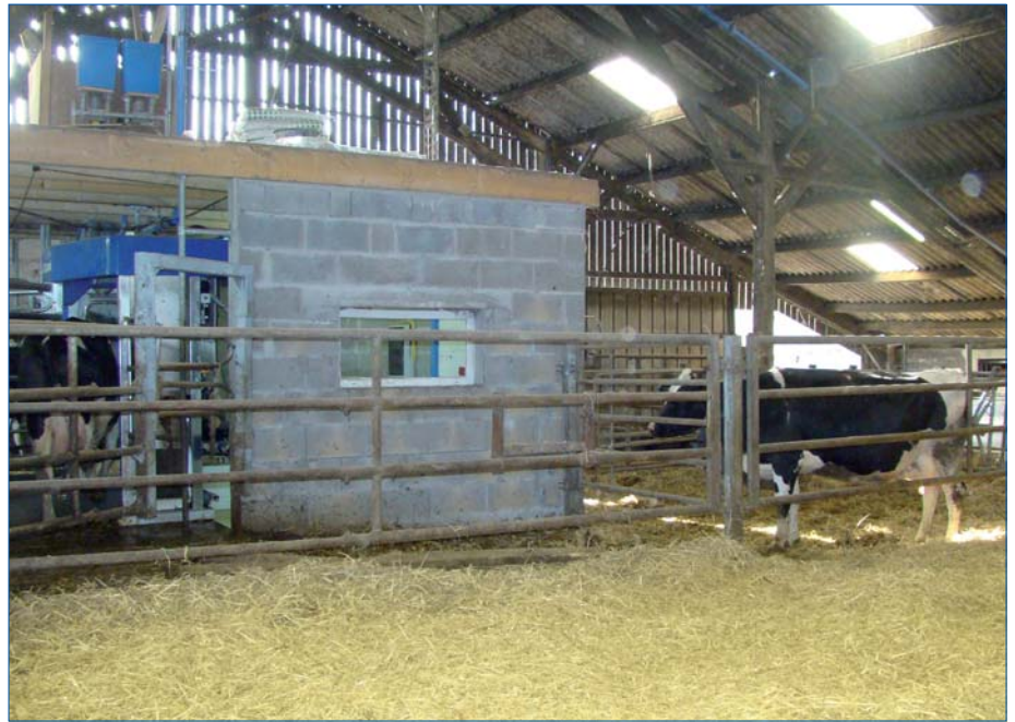
Un espace isolement contigu à la stalle du robot
