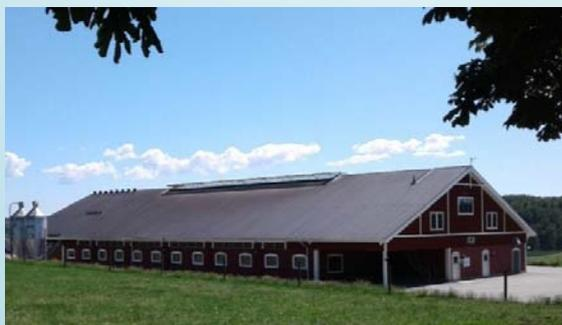
Le bâtiment vaches laitières est clos avec une ventilation à aspiration forcée et un faitage de toit ouvrant informatisé.
