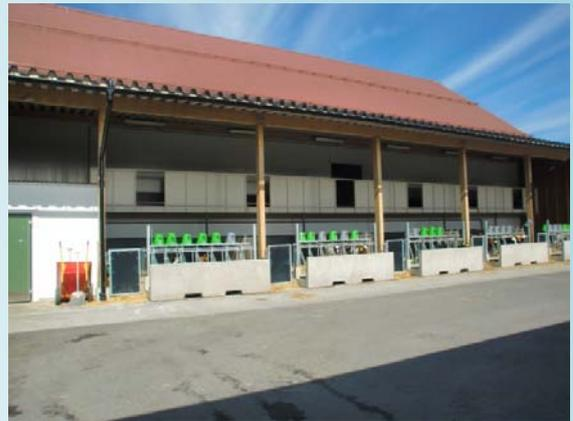
Logement ouvert des veaux en cases collectives avec fermeture possible en brise-vent
