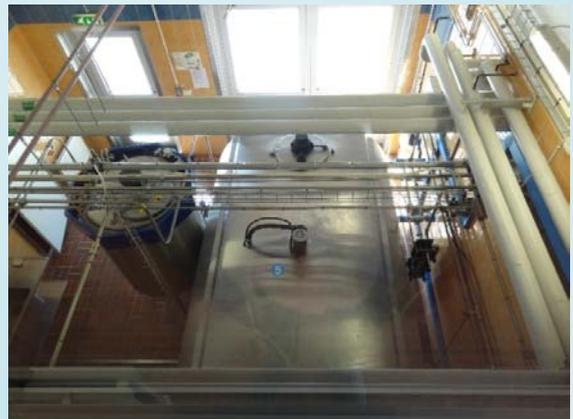
La laiterie comprend : un filtre à lait (MF250), un pré-refroidisseur à plaques, un tank tampon pour robot VMS, un tank à lait de 6000 litres et un récupérateur de chaleur pour la production d'eau chaude.
