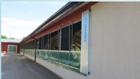
Le réglage des entrées d'air de la stabulation se fait manuellement
