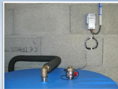
Figure 4 : Anode à courant imposé
