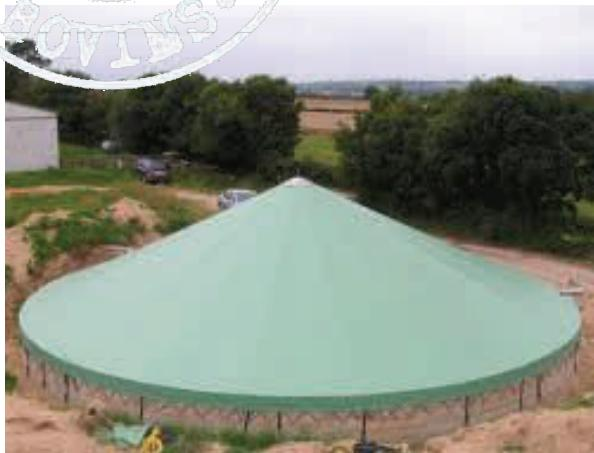
La couverture des fosses à lisier permet de limiter les apports d'eaux pluviales. Elle limite aussi les odeurs ainsi que les émissions de gaz dans l'atmosphère. Il existe plusieurs solutions pour couvrir les fosses, du système textile plus ou moins élaboré à la couverture charpente. De nombreux aspects techniques, économiques et climatiques doivent être pris en compte pour faire les bons choix.
