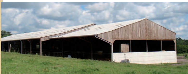
L'implantation le long des courbes de niveaux permet de limiter le terrassement et de protéger par le déblai la façade ouverte du bâtiment orientée sud.
