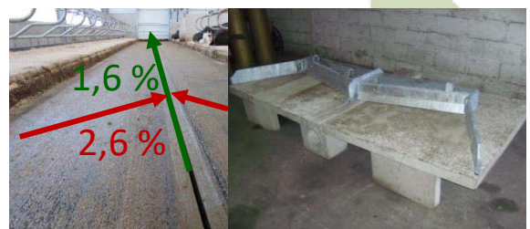
Sol en pentes transversales avec gouttière centrale avec racleur en W / © Idele et © CRD
