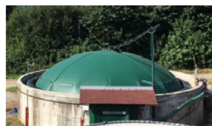
Couverture de fosse avec récupération de biogaz / Nénufar
