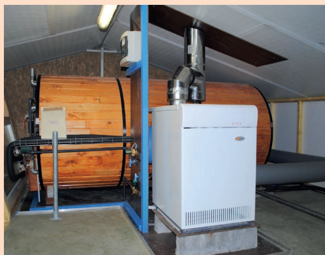
Chaudière au gaz à condensation et ballon d'accumulation.
