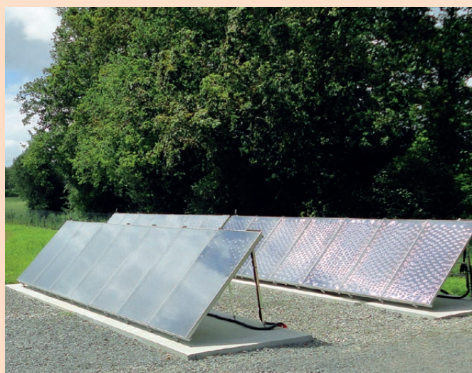
Panneaux solaires thermiques.
