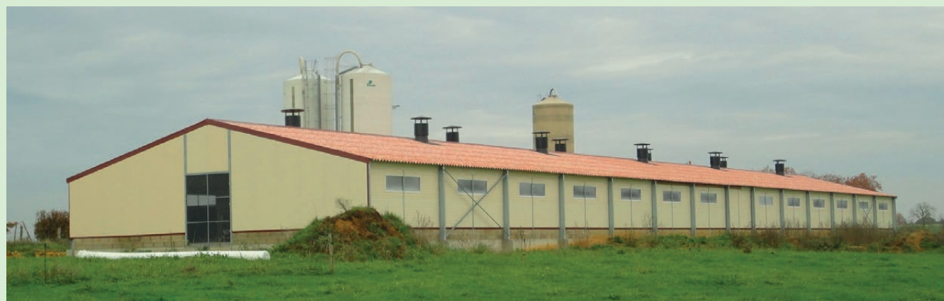
Bâtiment veaux de boucherie.
