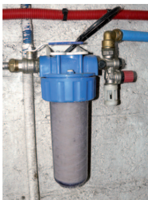
Avec un récupérateur de chaleur à plaques, la filtration de l'eau est recommandée
