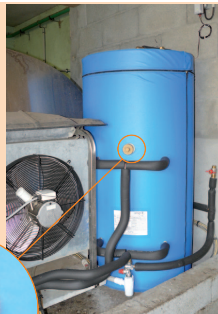
Résistance effectuant l'appoint de chauffe
