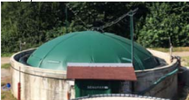
Couverture de fosse avec récupération de biogaz / Nénufar
