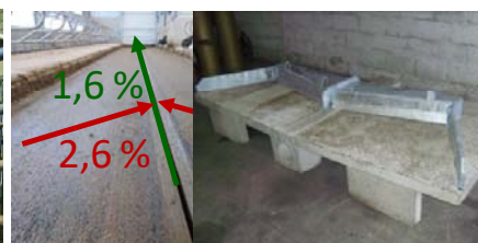
Sol en pentes transversales avec gouttière centrale avec racleur en W / © Idele et © CRD
