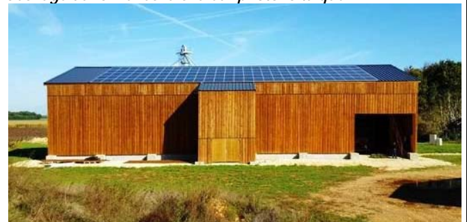
Système Cogen'air / société Base
