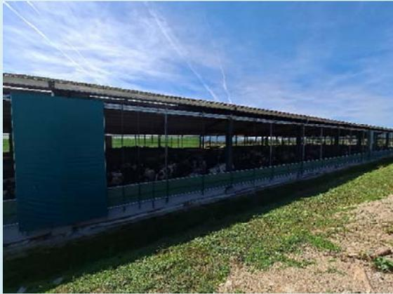
Les 4 faces du bâtiment sont gérées avec des filets brise vent réglables. L'éleveur abaisse le filet côté sud à partir de 16 °C pour protéger les vaches du soleil sur la partie couchage. Pas de ventilateur, ni de brumisation. Pas d'isolation en toiture (option non retenue car trop onéreuse selon les éleveurs). Pas de débord de toiture pour augmenter la zone d'ombre (option non retenue car trop onéreuse).
